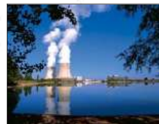
Centrale de Saint-Laurent-des-Eaux
