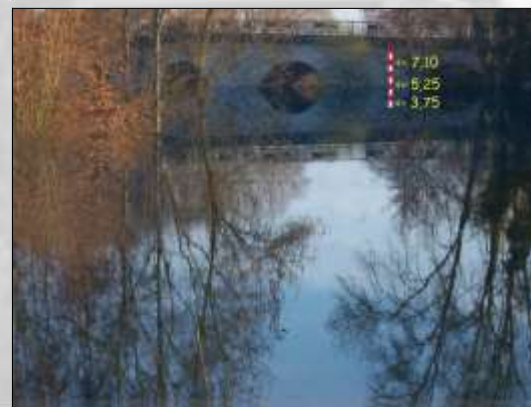
Simulation d'une crue à 5,25 m
